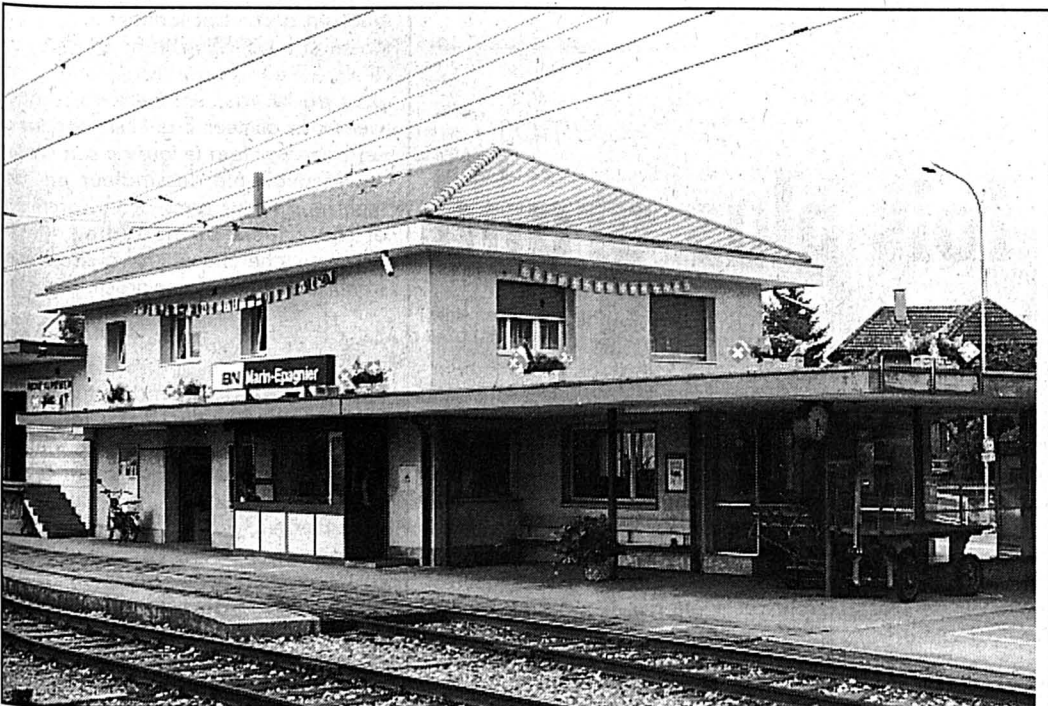
LA GARE TOUTE RÉNOVÉE - Cinq mois de travaux pour faire perdre à ce bâtiment «ses allures de bunker».
