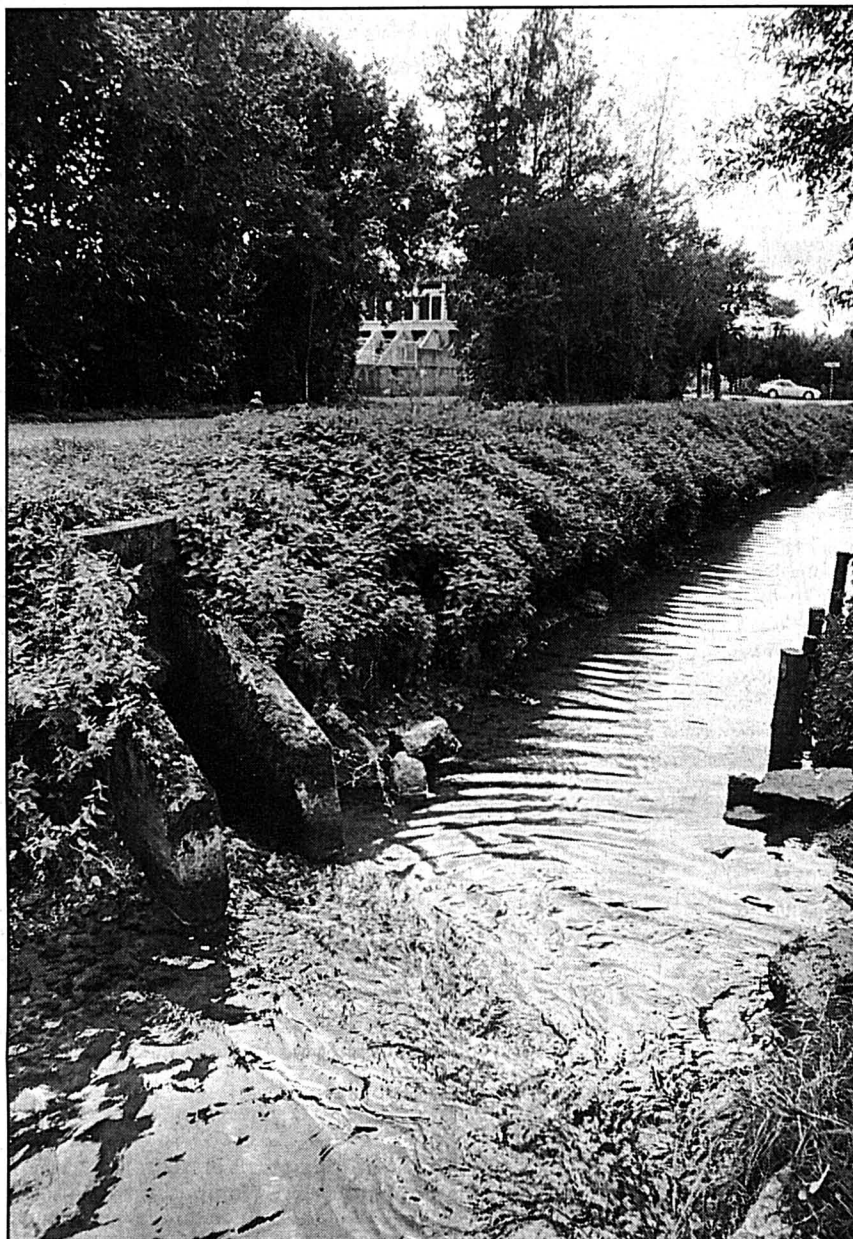
STEP - Après rénovation, les eaux traitées prendront le chemin de la grande Thielle au lieu d'être rejetées dans le ruisseau de la petite Thielle.
