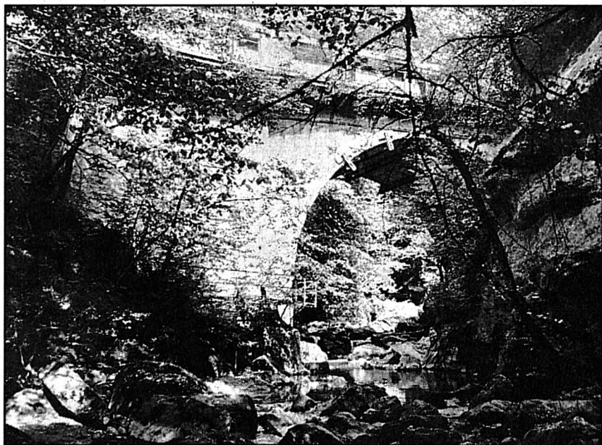
L'ACTUEL PONT-NOIR - Le gibier pourra passer sous les futurs viaducs par des cheminements aménagés au pied des falaises. axb-E
