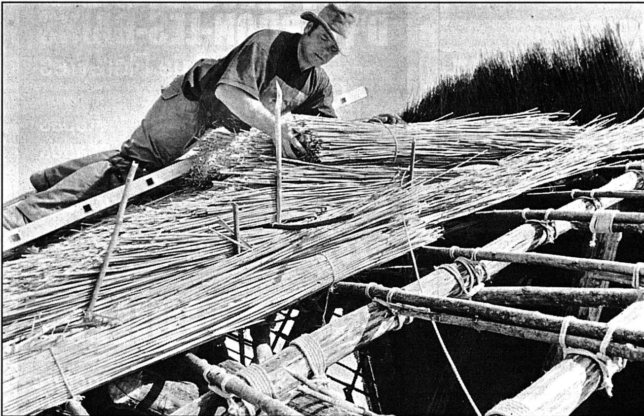
CHARPENTE EN ROSEAUX ET EN PAILLE — Pour bâtir cette réplique de l'âge du bronze, les techniques de l'époque sont utilisées: pas de métal, pas de ciment, ni briques.
