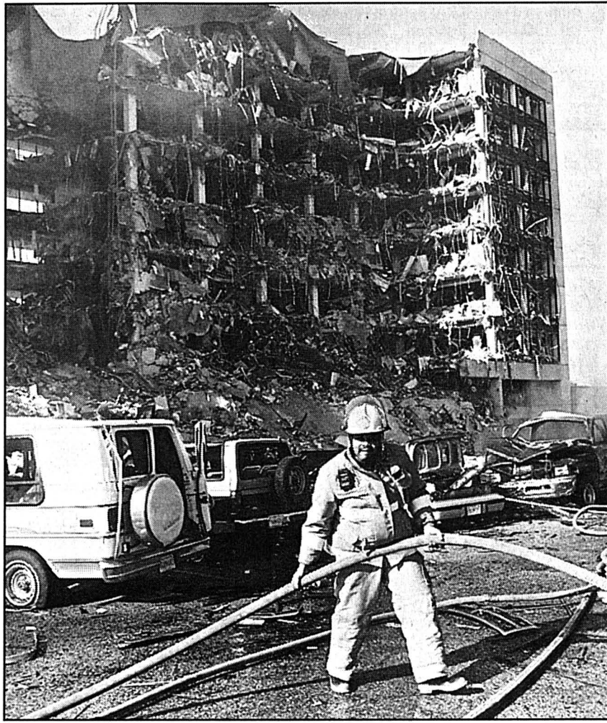
IMMEUBLE SOUFFLÉ – Sous la violence de l'explosion, l'immeuble s'est effondré comme un château de cartes. /ap
