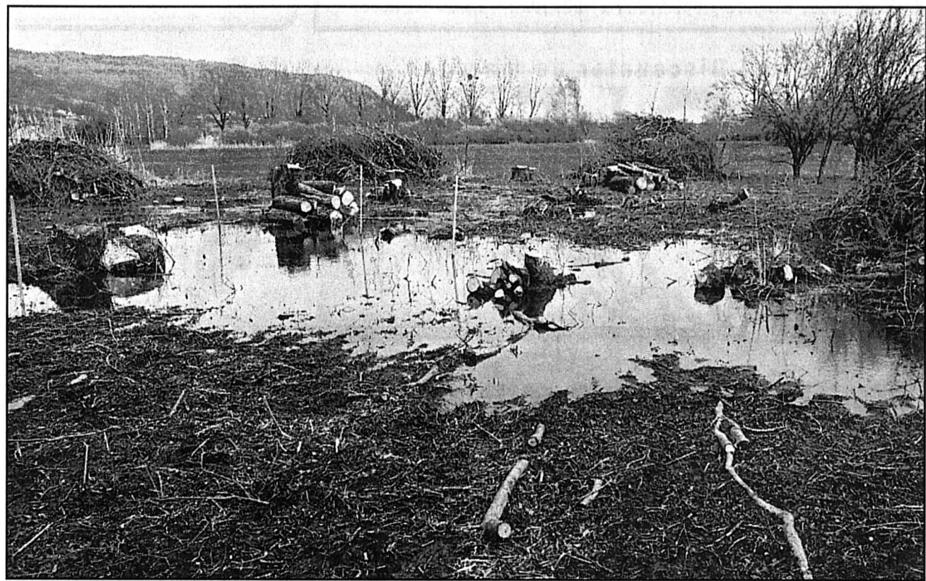
LA FUTURE MARE - Bien qu'elle soit déjà «en eau», il faut attendre que le terrain sèche pour pouvoir la creuser correctement.
