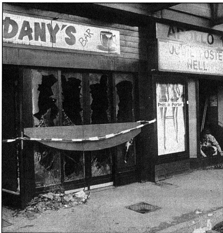
LE BAR ET LE CINÉMA - Un incendie très probablement d'origine criminelle a ravagé, hier vers 3 h du matin, le Dany's, bar de Neuchâtel. Installé juste à côté, le cinéma Apollo, a été envahi par la fumée. Selon les premiers éléments de l'enquête, des inconnus se sont laissés enfermer dans le cinéma après la fermeture et ont ensuite pénétré dans le bar pour y voler une bourse de sommière avant de mettre le feu à des matériaux inflammables. Le gérant du cinéma a dû se résoudre à y supprimer toutes les projections au moins jusqu'au début de la semaine prochaine. Pierre Treuhardt-E
