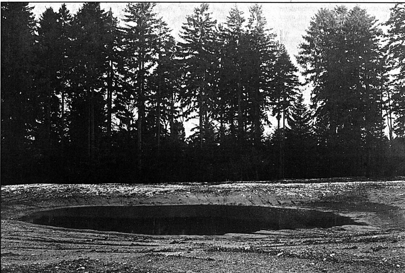
ÉTANG DU BOIS-DU-MILIEU - Hier un chantier, demain une charmante pièce d'eau dans un milieu naturel préservé.
