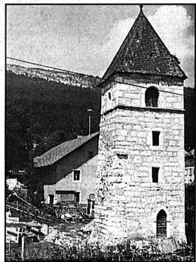
TOUR COMMUNALE - Aujourd'hui isolée, la tour était jadis rattachée à un bâtiment. archives.
