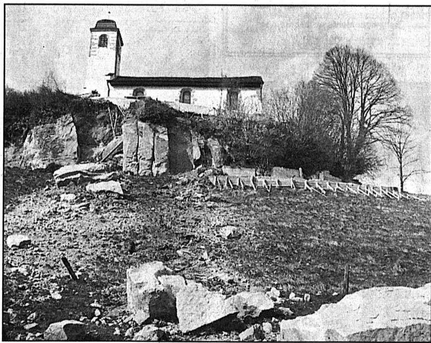
FALAISE - Des rochers de plusieurs tonnes ont roulé dans le champ en contrebas et d'autres menacent encore de tomber. pd.-E
