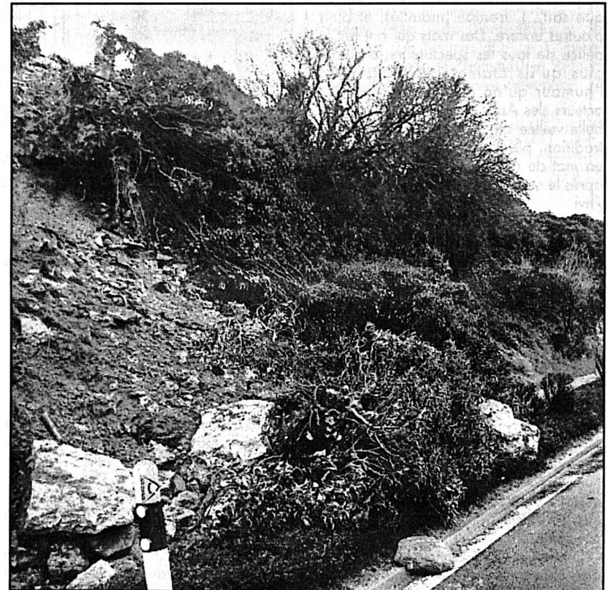
ÉBOULEMENT - Quelque cent mètres cube de matériaux ont partiellement recouvert la route nationale entre Serrières et Auvonnier. ptr-E
