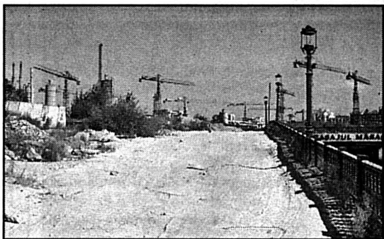
BUCAREST - Alors que sévit une grave crise du logement, les chantiers abandonnés sont légion.
