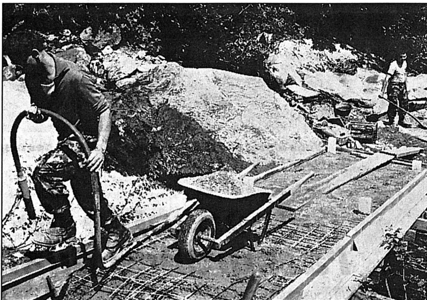
TOUS LES GENRES - La Gazette montre qu'un cours de répétition, ce n'est pas que de la garde, du tir et des marches (ici la réfection d'un pont en Valais).
