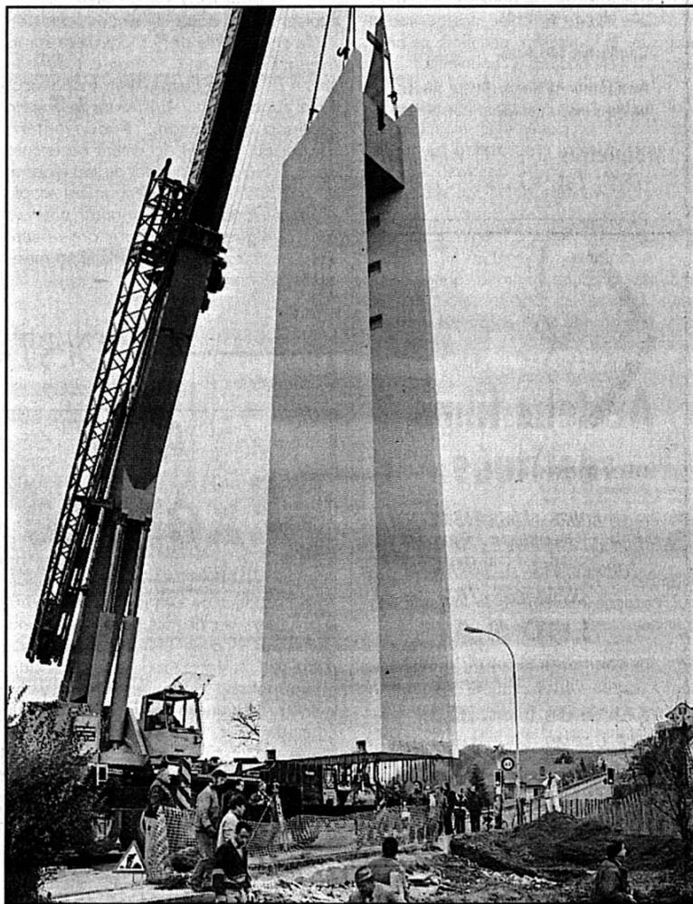
OPÉRATION DÉLICATE - Le clocher est suspendu au bras de la grue. alg. E
