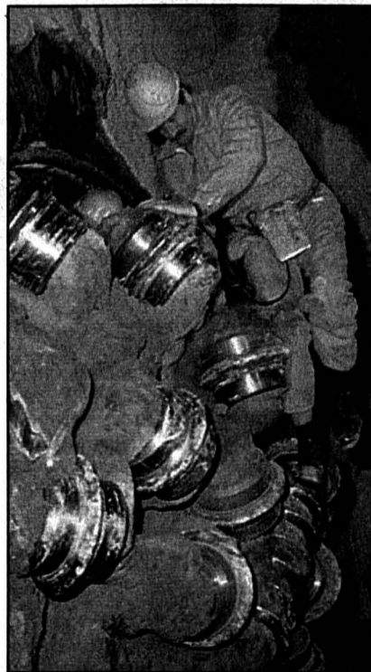
SOUS LA VUE - Un immense chantier qui porte ses fruits.
