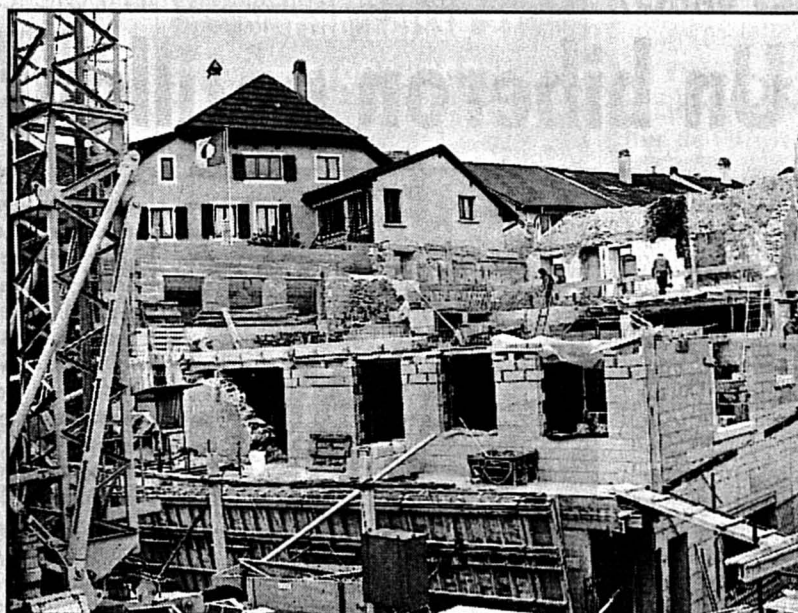
CHANTIER - L'agrandissement du collège de Gorgier. /clg-E
