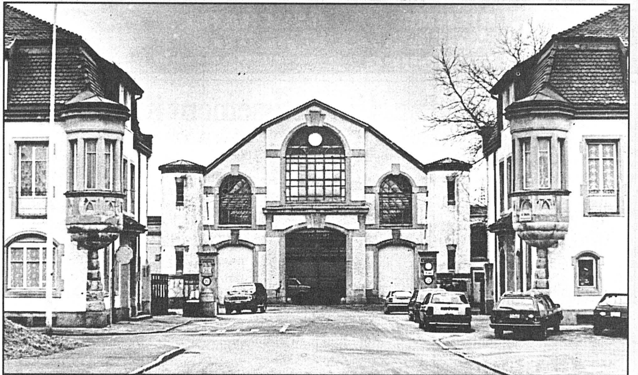
ABATTOIRS CHAUX-DE-FONNIERS - Leur état laisse à désirer, mais ils ne sont pas dénués d'atouts.
