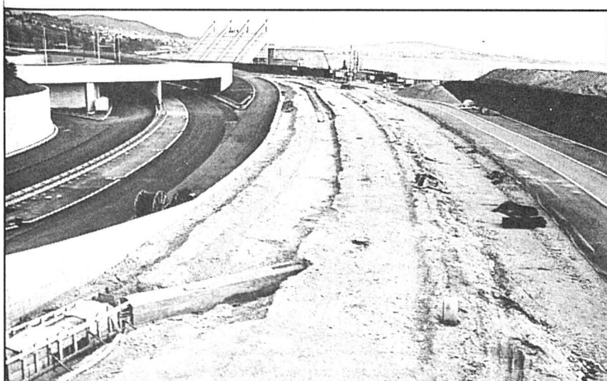
NID-DU-CRÔ - Vu de l'ouest, de la passerelle pour piétons enjambant la jonction, le secteur du parking des piscines dont la moitié sud est déjà aménagée. Sur la partie nord, les travaux de pose des canalisations progressent rapidement.
