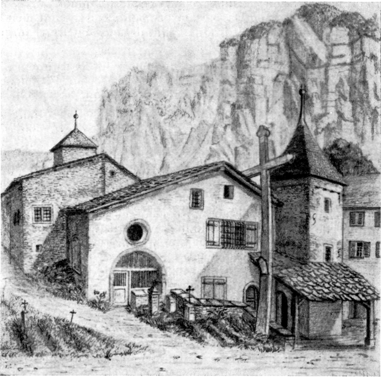
Sembrancher. La maison de ville flanquée de la tour et, derrière, la chapelle Saint-Panrace (Dessin d'E. Wick, 1864-1868)
