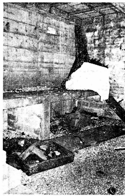
LOGES SOUS LA SCÈNE.- Les seuls utilisateurs sont des groupes nocturnes...
