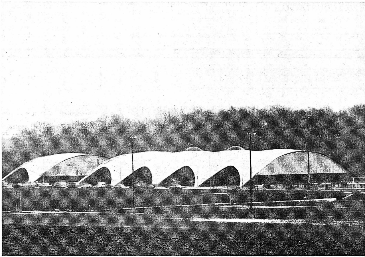
Cet impressionnant ouvrage en voie de réalisation.
