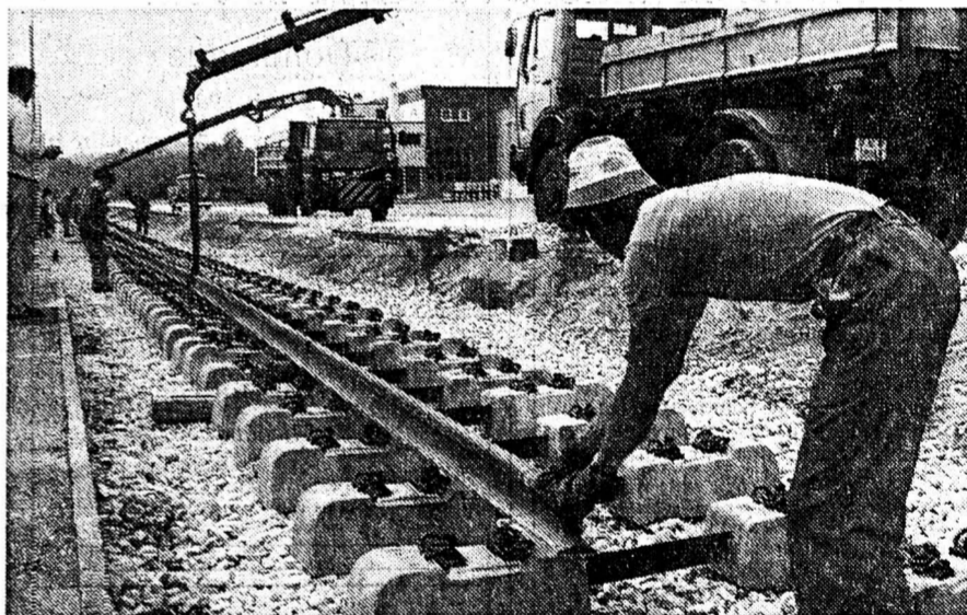
TRAVAUX. — Barres longues, traverses de béton et attaches « Pandrol »: les trois conditions d'une voie moderne.
