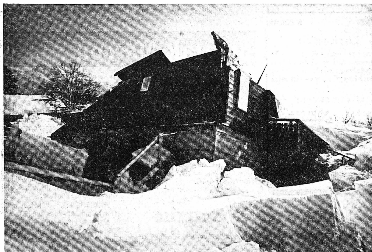
Les lieux du drame : le chalet qui était construit sur le garage s'est effondré.
