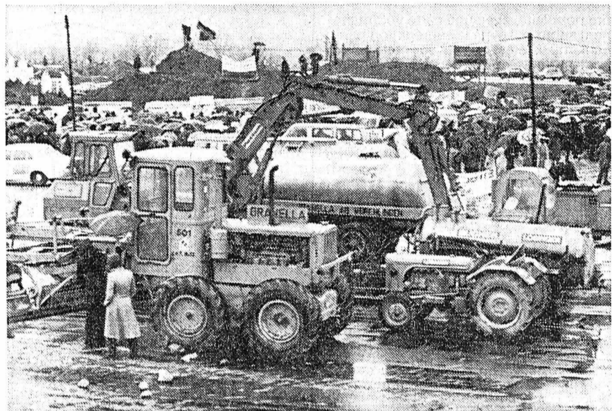
Sur le chantier de la future centrale. (Keystone)
