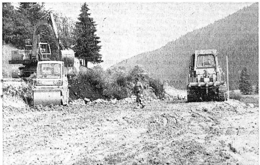
Les travaux, à l'entrée des Verrières. (Avispress-P. Treuthardt)
