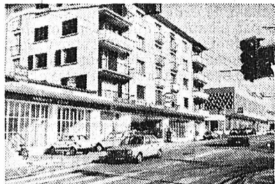
Garage MARCEL FACCHINETTI
