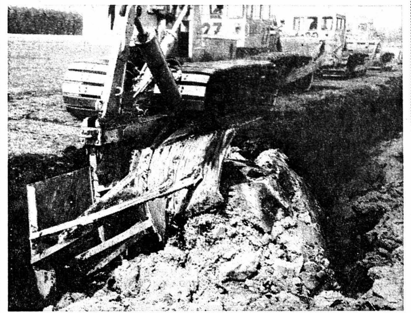
Légèrement décalés pour ne pas écraser le terrain, les quatre bulldozers qui forment cette charrie gigantesque. Profondeur du sillon: 1 m 90. (Avipress-P. Treuthardt)
