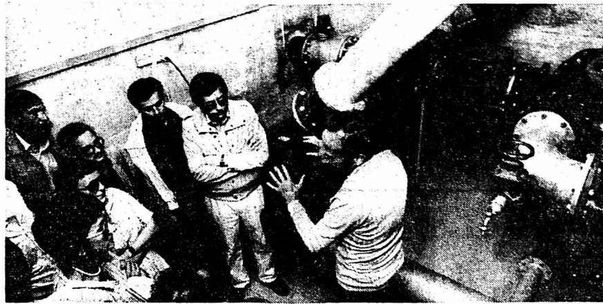
La visite des installations techniques.
