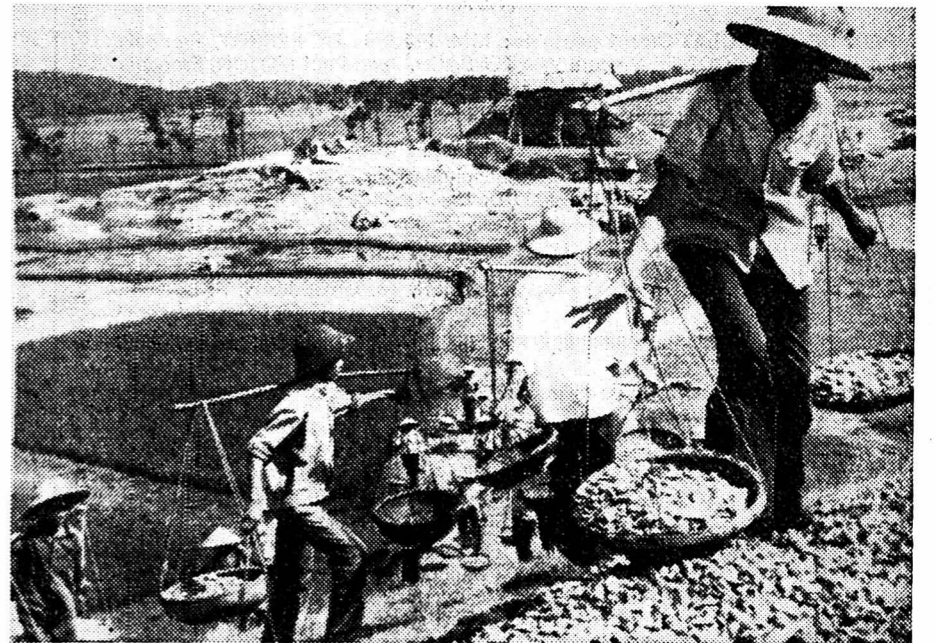
Construction d'une route à la vietnamienne dans le nord du pays près de la Chine. (Keystone)
