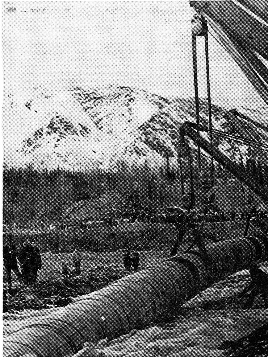
Mise en place de l'oléoduc à travers la rivière Tonsina gelée.
