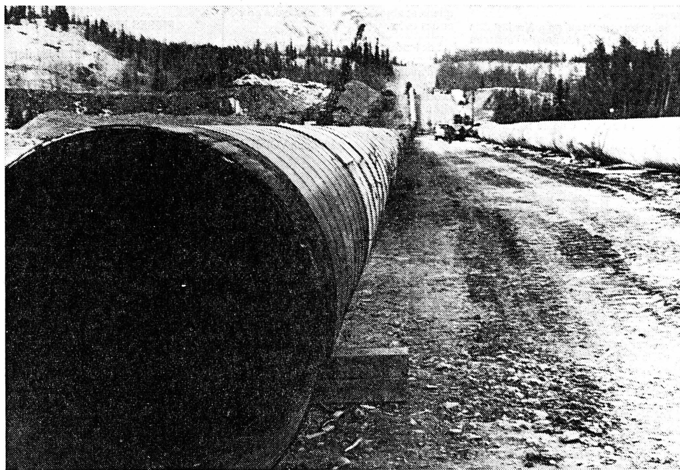
L'oléoduc: 1280 km de long et 1 m 20 de diamètre.
