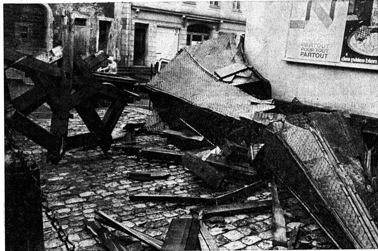
Le clocher du temple de Boudry n'a pas résisté au vent soufflant à quelque 160 km/h.
