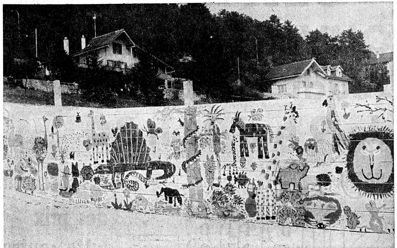
Une bonne initiative : Les enfants ont dessiné les palissades du chantier Coop, mises à la disposition par la société en vue d'une expérience qui s'est révélée une réussite. En effet, ces dessins attirèrent le regard des passants et donnaient une autre dimension au chantier. (Photo Coop)
