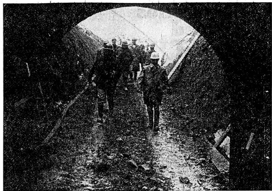
Après la dernière explosion, la descente dans la galerie.
