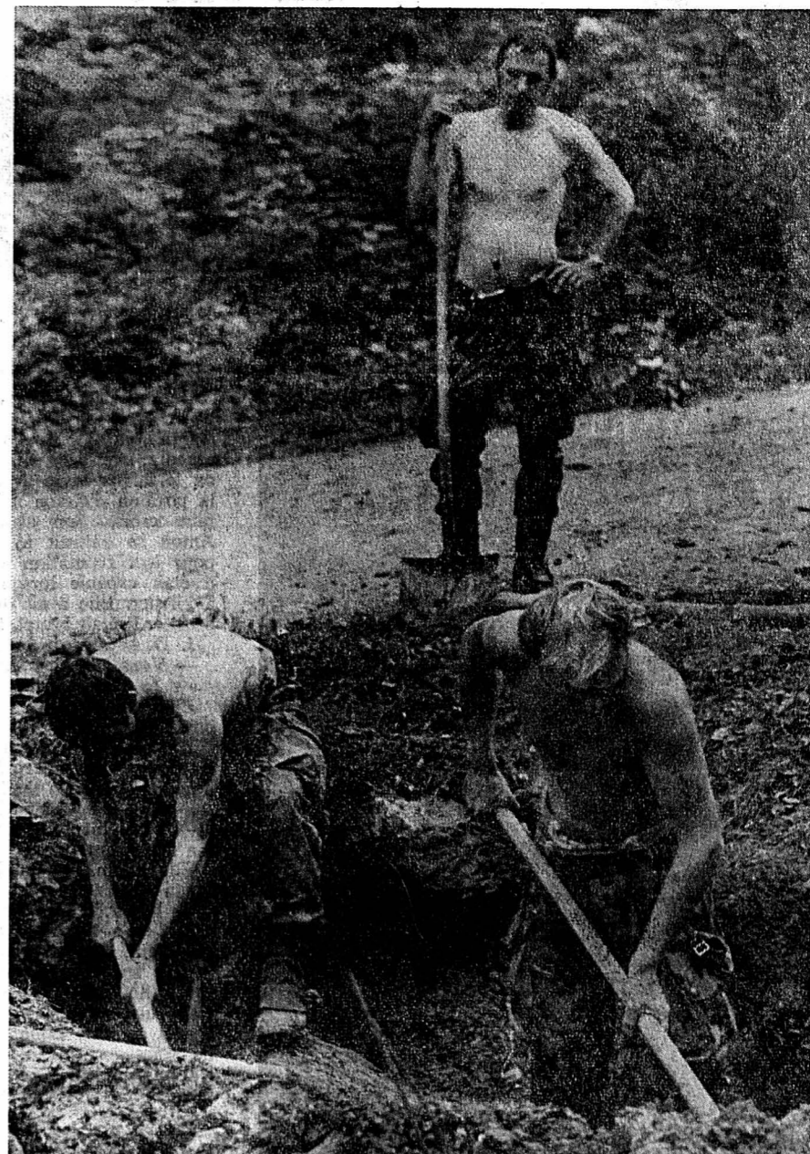
On a beaucoup creusé durant ce cours, creusé et encore creusé. La chaleur aidant, certains allègements de tenue ont été les bienvenus. (Avipress RIH)
