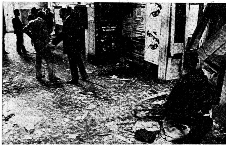
La gare de Kings Cross après l'explosion.
