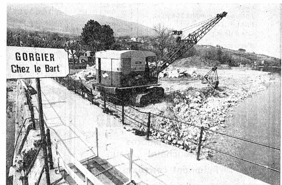
Une vue de ce remblayage. On aperçoit derrière la grue les gros blocs de pierre qui seront déversés devant l'ouvrage.
