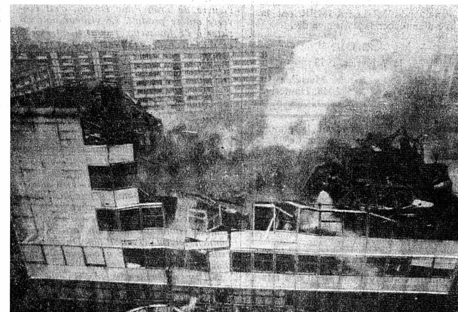
Ce qu'il reste du collège de la rue Pailleron alors que le jour vient de se lever.
