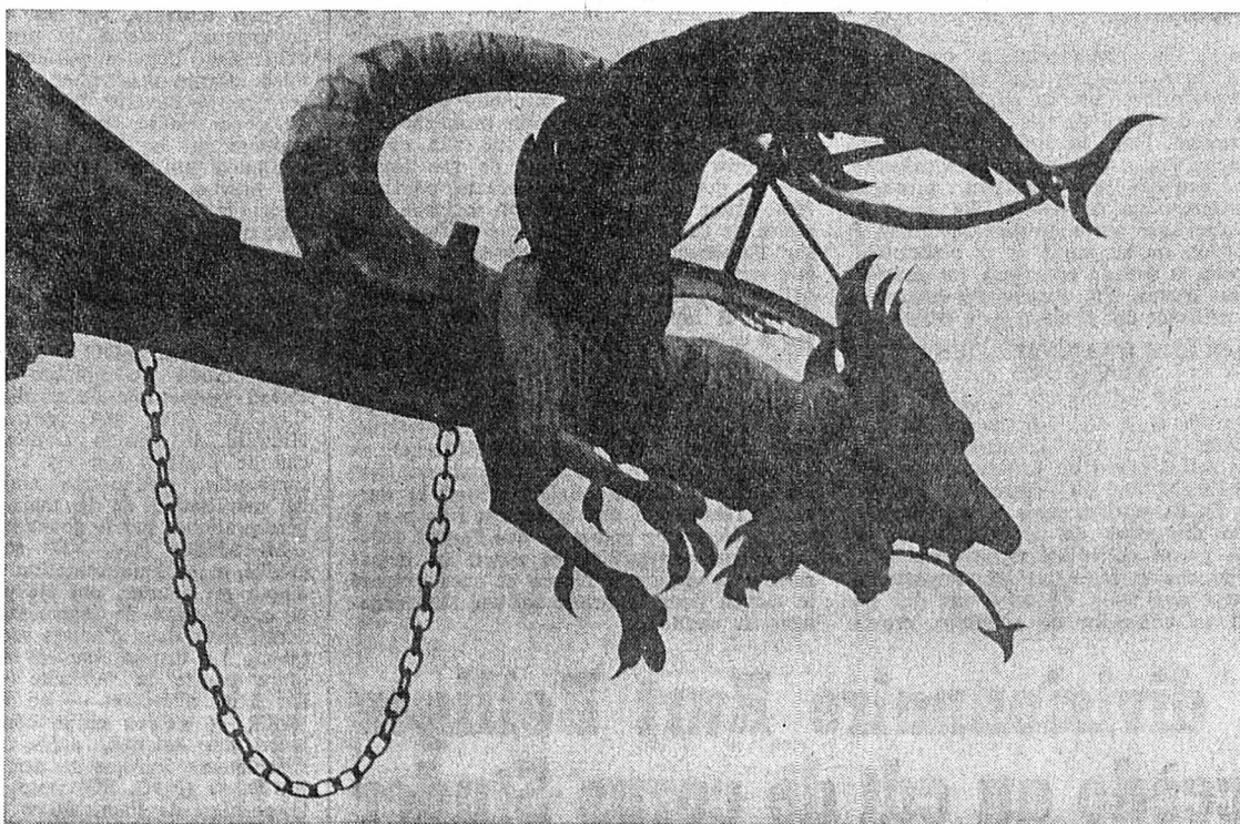
Une des célèbres gargouilles du splendide Immeuble restauré place des Halles 8.
