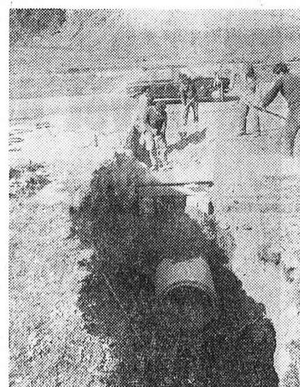
Le travaux de traversée de La Pénétrante pour la pose du collecteur des eaux usées à l'ouest de la localité. (Avipress - Fyj)
