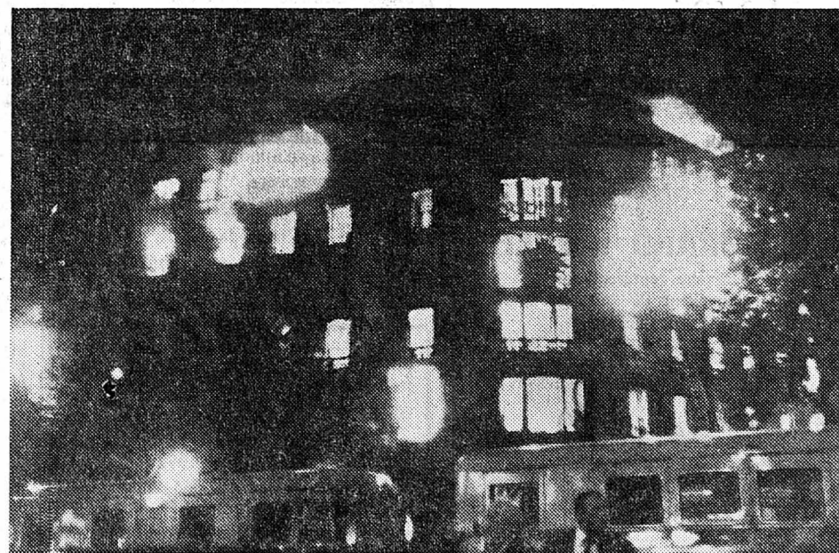
L'incendie de l'immeuble « Publicis ».
