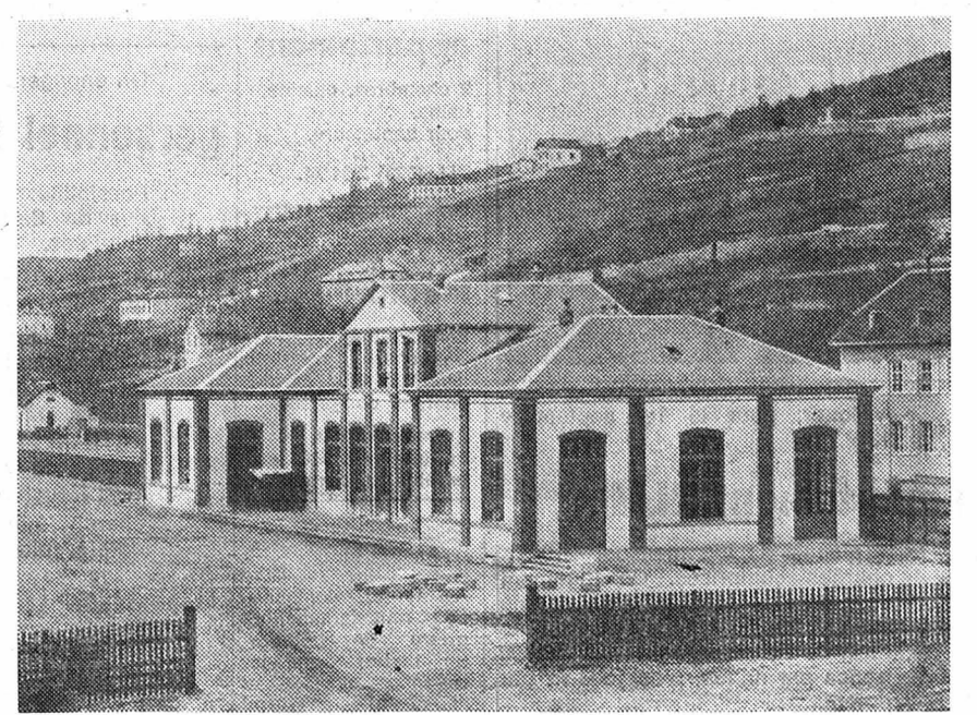
La gare de Neuchâtel vers 1859. Elle fut rebâtie en 1882 et le sera une nouvelle fois en 1936.
