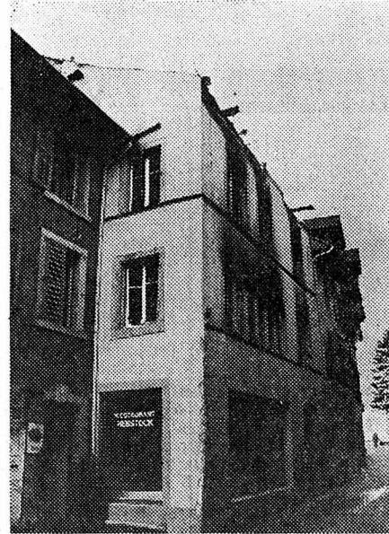
La façade du bâtiment brûlé.
