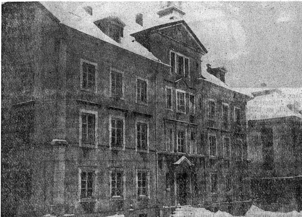
Le bâtiment qui, si le projet est accepté, serait démolé au printemps pour faire place au centre médical.
