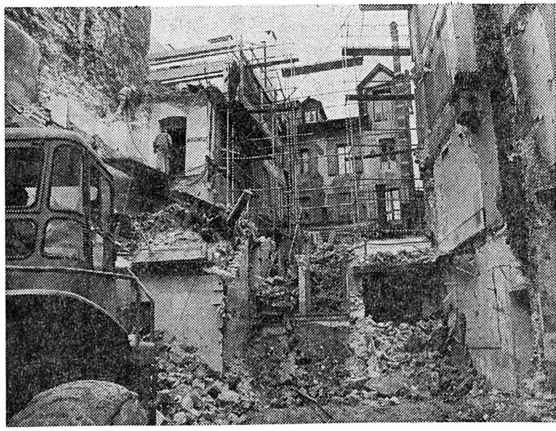
● NEUCHÂTEL fait petit-à-petit peau neuve. Ces jours-ci, c'est une entreprise qui procède, pour le compte d'une grande banque de la ville, à la démolition d'un ancien immeuble
