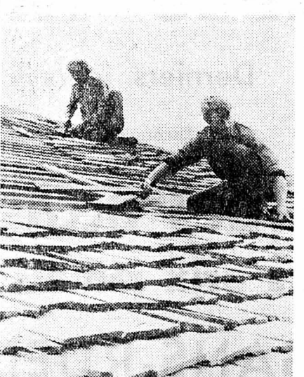
La pose des bardeaux: lentement, choisies dans un bois sans nœud, les planchettes recouvrent le pan côté bise du toit.
