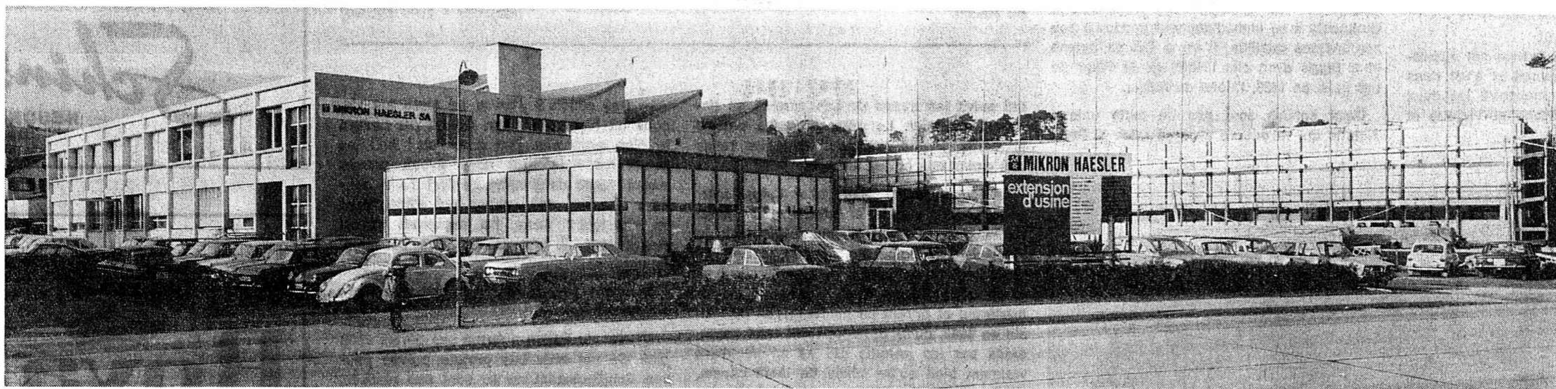
EXTENSION DE NOTRE USINE, FÉVRIER 1971
