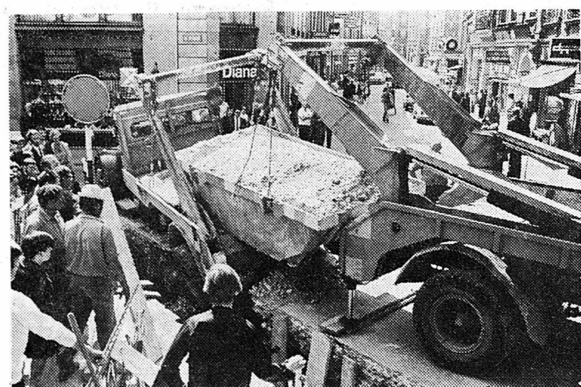
Il a fallu déployer de longs efforts pour sortir ce véhicule de sa fâcheuse position. La chaussée a cédé sous le poids des essieux arrière et le lourd
