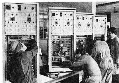
Des élèves mécaniciens-électriciens en courant fort procèdent au montage d'armoires de commandes d'automatique destinées à l'industrie.
