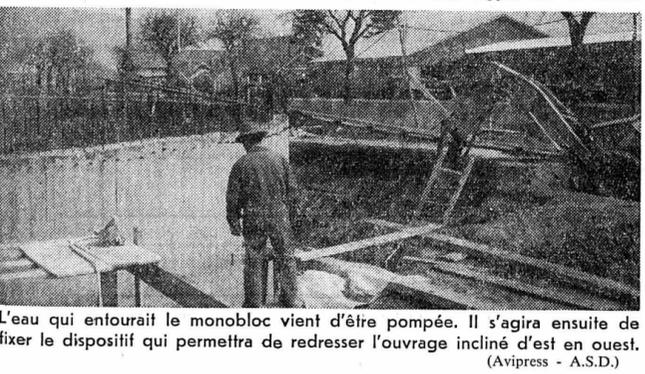
L'eau qui entourait le monobloc vient d'être pompée. Il s'agira ensuite de fixer le dispositif qui permettra de redresser l'ouvrage incliné d'est en ouest. (Avipress - A.S.D.)
