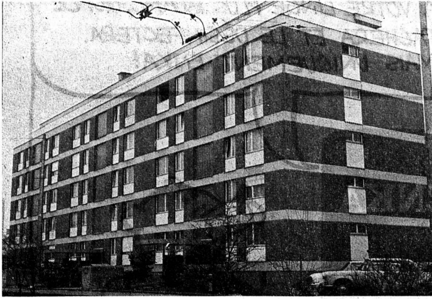
Un des grands blocs construits à l'est de la ville de Bienne où les locations ne sont pas celles des HLM. Mais où? Réponse: A la route d'Orpond.
