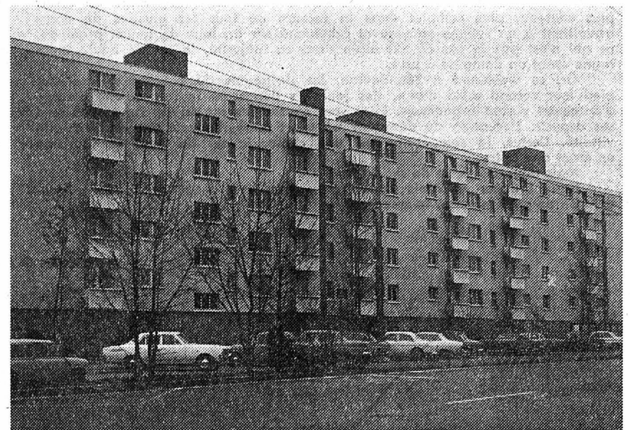
Voici quelques-uns des grands blocs construits récemment à l'est de la ville. — Mais où? (Avipress - Guggisberg)
