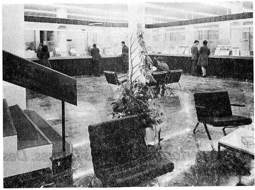
Le hall de réception rénové
