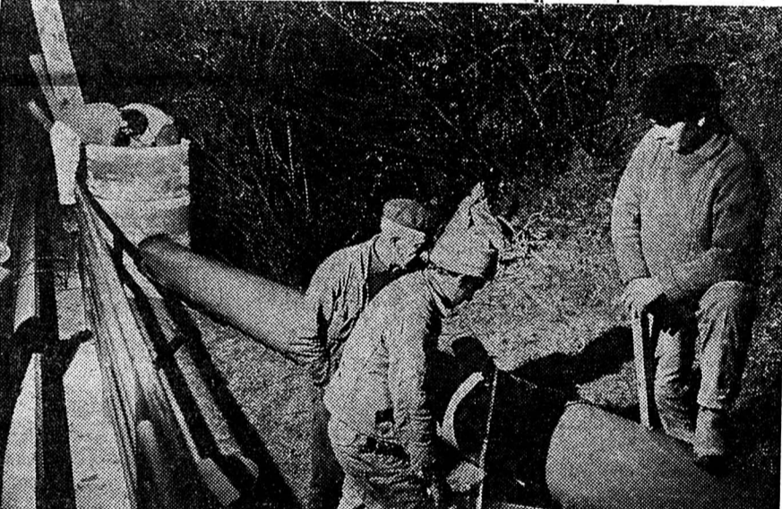
Pose de la conduite. (Avipress - J.-P. Bailloy.)
